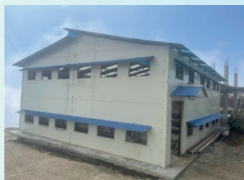
NAMP-PIU, Okhaldhunga मा सञ्चालित रस्टिक स्टोर
