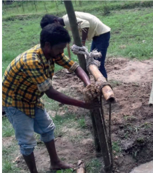
चित्र नं. २ : स्थलगत तयारी पश्चात Pilot hole खन्ने कार्य
