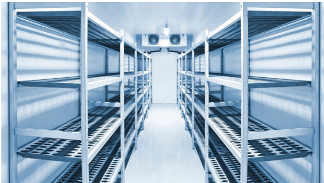
चित्र ३: खाद्य-ग्रेड स्टेनलेस स्टिल न्याक र आन्तरिक हावा प्रवाह प्रणालीको लेआउट
