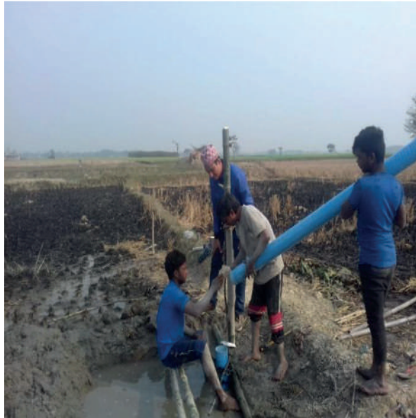
चित्र नं.३: बोर होल तयार पश्चात Ribbed filter जडान कार्य
