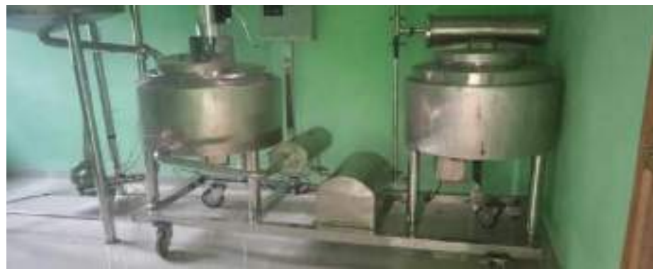
मह प्रशोधनका लागि प्लाण्ट सहितको घर निर्माण
